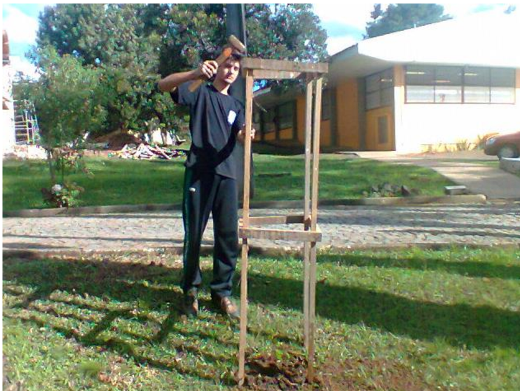
Figura 6 – Fixação das gaiolas (ou quadros) de proteção
