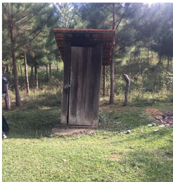
Ausência de infraestrutura básica
