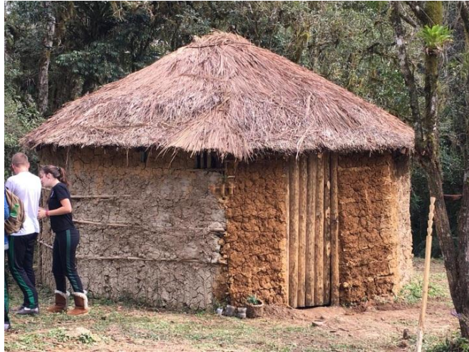
Modelo de construção tradicional como os africanos construíam com taipa
