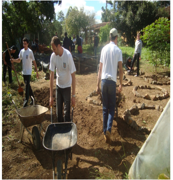
Figura 10 - Montagem dos canteiros
