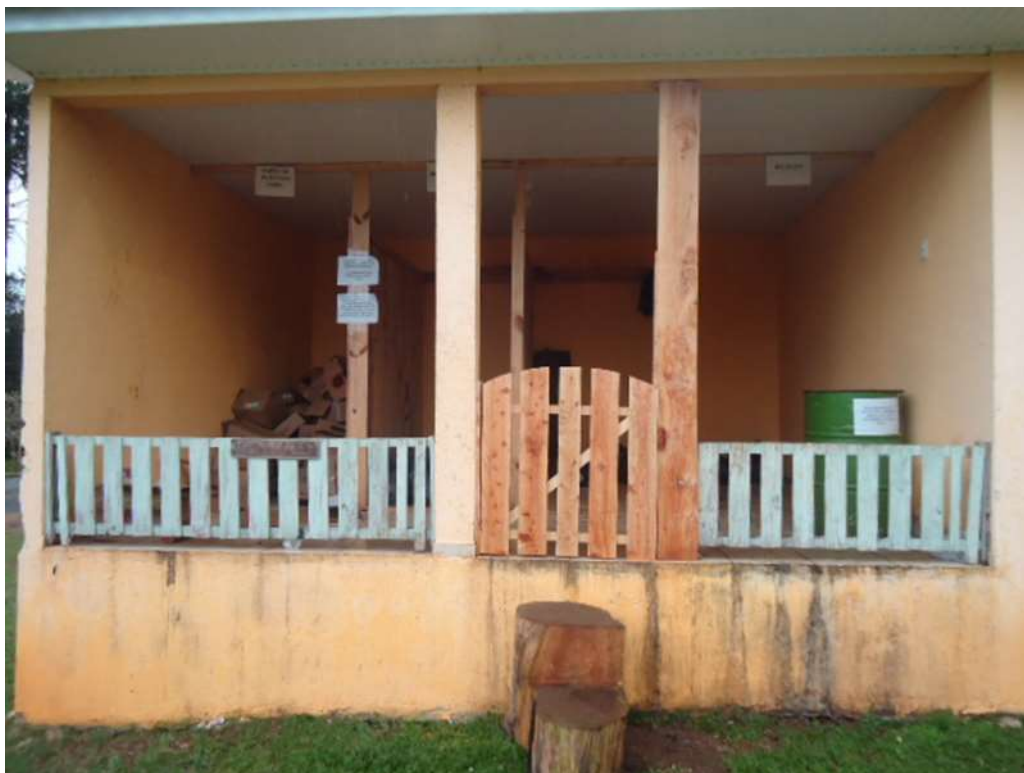
Fachada do local de disposição dos resíduos
