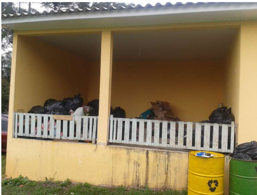
Local de disposição dos resíduos antes da intervenção
