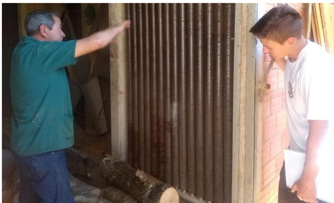
*Radiadores por onde passam os vapores de água, os quais aquecem o ar para secagem da madeira*
